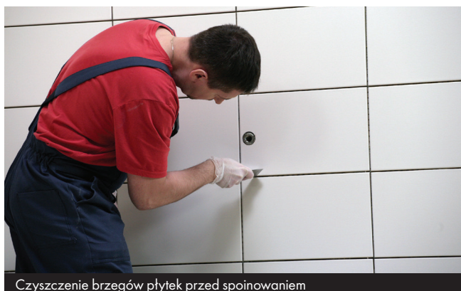
Czyszczenie brzegów płytek przed spoinowaniem
